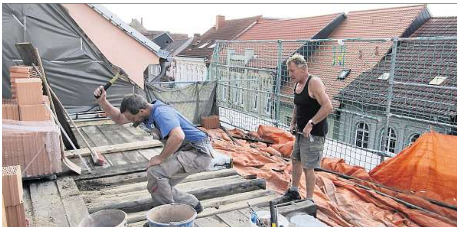
Das Haus Steinweg 18 wird zu einem Mehrgenerationenhaus umgebaut. Derzeit wird der Dachboden saniert, aufgemauert und danach ein neues Dach aufgesetzt. Uwe Weinberg und Wilfried Fröhlich (von links) von der Firma KGW Bau bei Dacharbeiten. Fotos (2): Claudia Bioly
